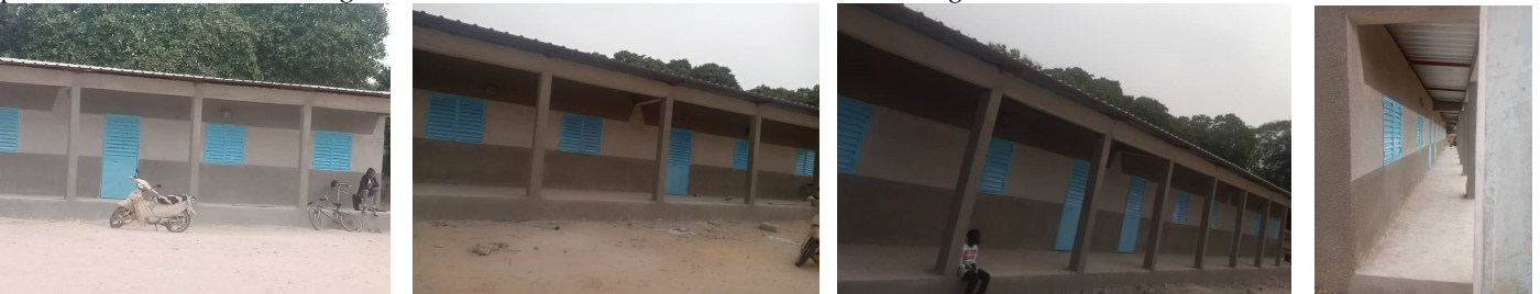
Eindelijk: Het eindresultaat mag er zijn. De buitenkant is met 2 grijs tinten cement bespoten. Luiken en deuren contrasteren mooi.
