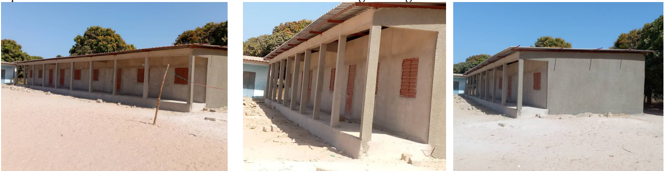
Op 18 februari was de dakconstructie klaar. Het gebouw is aan de zijkant en de achterkant met een afwerkende cementlaag bespoten. De voorkant wordt tegelijk met het binnenschilderwerk met gekleurde cement bespoten. Omdat er een probleem was met de levering van cement moest hiervoor tot half maart worden gewacht.
