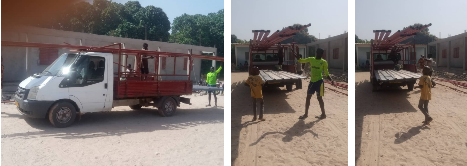
Het materiaal voor de dakconstructie werd op 14 februari 2021 op het terrein afgeleverd.
