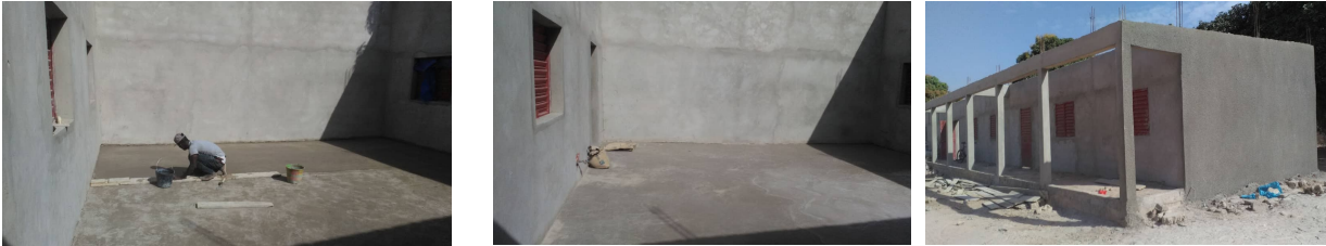
Begin februari werd de vloer afgesmeerd en de buitenkant aan de achter- en zijkanten met een laag cement bespoten.
